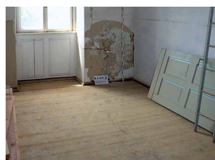
Abb. 5: Wand- (oben) und Deckenfelder (unten) mit Mess-Sensoren/Thermografie
