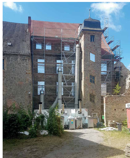
Abb. 3: Ertüchtigung des Dachwerks und Erneuerung der Dacheindeckung
